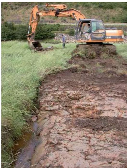
L'argile est prélevée sur une bordure du fossé, en amont du bouchon, sous la forme d'un fasciés en pente douce pour diversifier le profil des rives et obtenir notamment une mare favorable au développement de ceintures de végétation aquatique.
