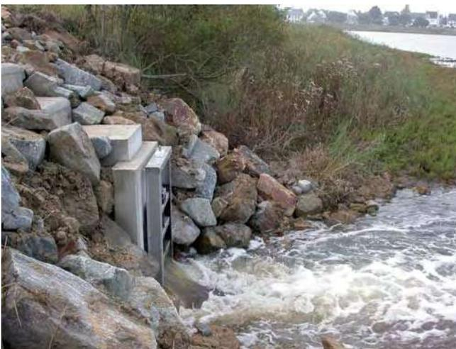
Vanne marais-lagune (côté lagune), ouverte pour baisser le niveau de l'eau dans le marais.
