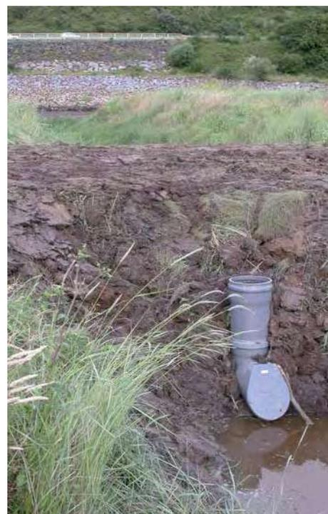
Bouchon d'argile en travers d'un fossé de drainage, équipé d'une buse et d'un clapet à té. Un seuil de trop-plein est posé sur le té.
