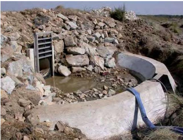
Vanne marais-Blavet en cours de chantier et son seuil à batardeau permettant une diminution du temps de vidange du marais, le cas échéant.
