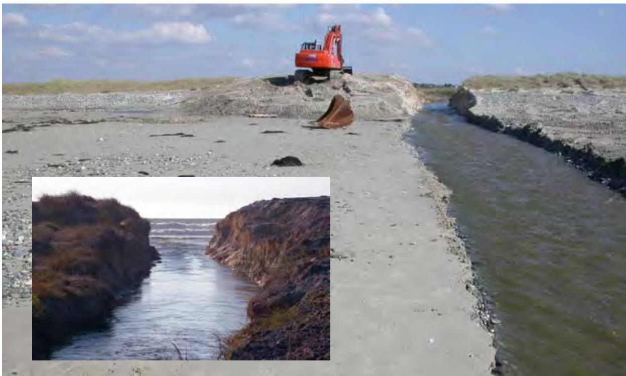
Photos 24, 25 et 26 - Restauration d'un exutoire pour l'étang de Trunvel, quinze ans après le colmatage de la brèche naturelle.
