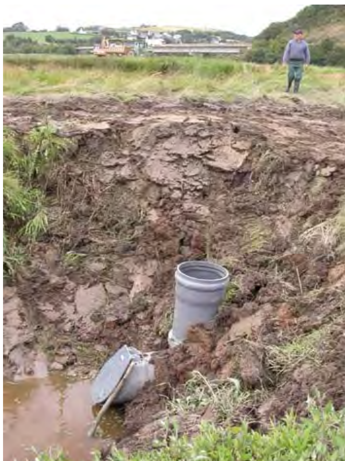
Photo 21 - Dans les marais de Rosconnec, buse et clapet posés sous le bouchon argileux isolant le fossé de l'Aulne. On aperçoit également un élément de seuil posé sur le T.
